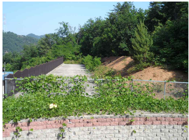
상부 성토부 전경
