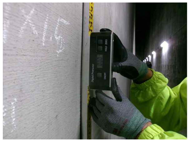
경사계를 이용한 경사도 측정사진
