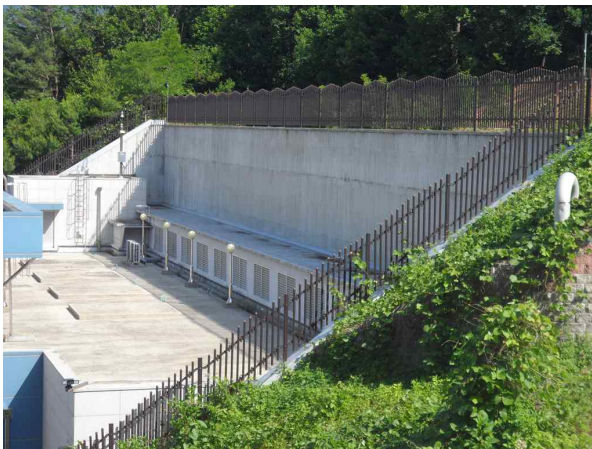
옹벽 상단 전경
