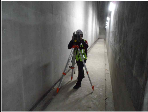
광파기를 이용한 측량 작업
